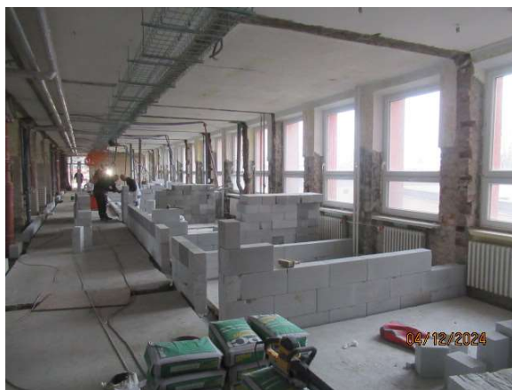
OBRÁZEK 4: PRŮBĚH REKONSTRUKCE DĚTSKÉHO ODDĚLENÍ V KŘÍDLE A – STANICE VĚŠŠÍCH DĚTÍ
